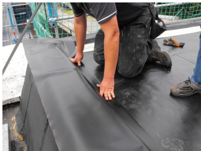
An der Schleuse in Dietfurt wurde die Attika mit einer Wolfin-Bahn abgedichtet.
