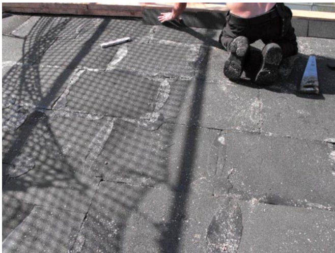
Die Dachfläche erhielt eine Wärmedämmung aus Schaumglas.
